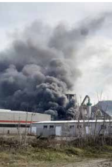
Le 21 décembre 2024, d'épais nuages noirs s'échappent toujours des cheminées de la cimenterie.
